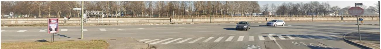
La Consulta sottolinea diverse criticità all'incrocio con via Arbe. L'attuale progetto prevede una deviazione tortuosa, con angoli retti e una forte riduzione a 2,0m della sezione ciclabile bidirezionale, con alte possibilità di collisioni dovuto all'intreccio di flussi pedonali e ciclabili.
